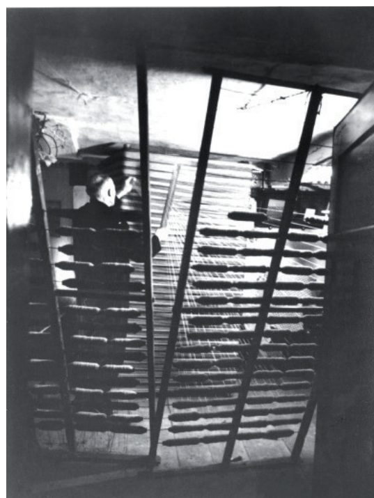
Abb. 39 und 40 Handweber beim Zetteln (Schweifen, Schären)
