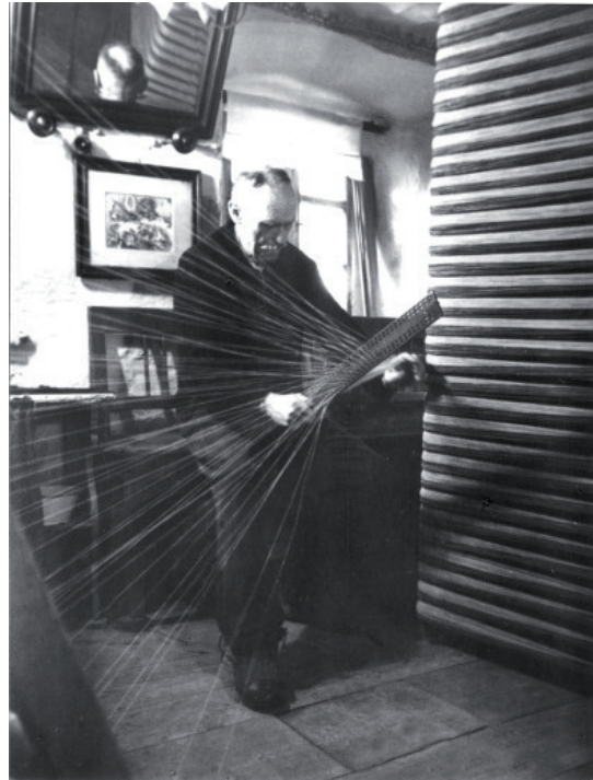
Abb. 37 und 38 Handweber beim Zetteln (Schweifen, Schären)
