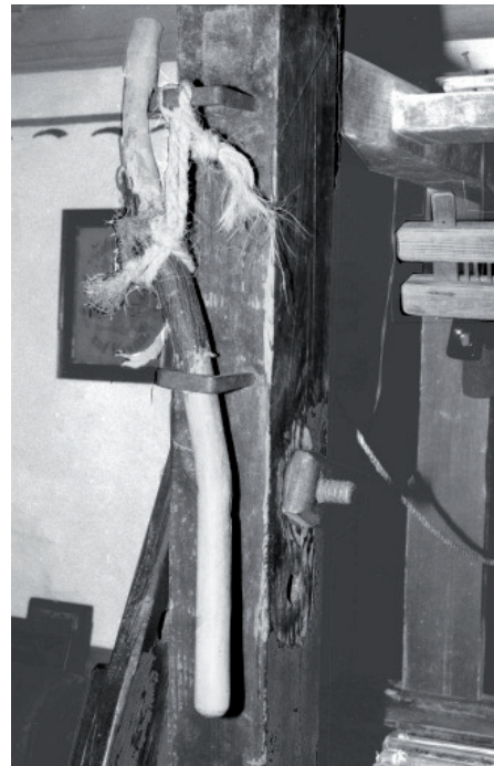
Abb. 51 Aufbäumprügel an einer Webstuhlsäule (Weberhausmuseum Neudorf)
