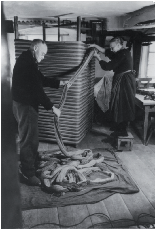
Abb. 43 Abnehmen der fertigen Kette vom Zettelrahmen im Frankenwald
